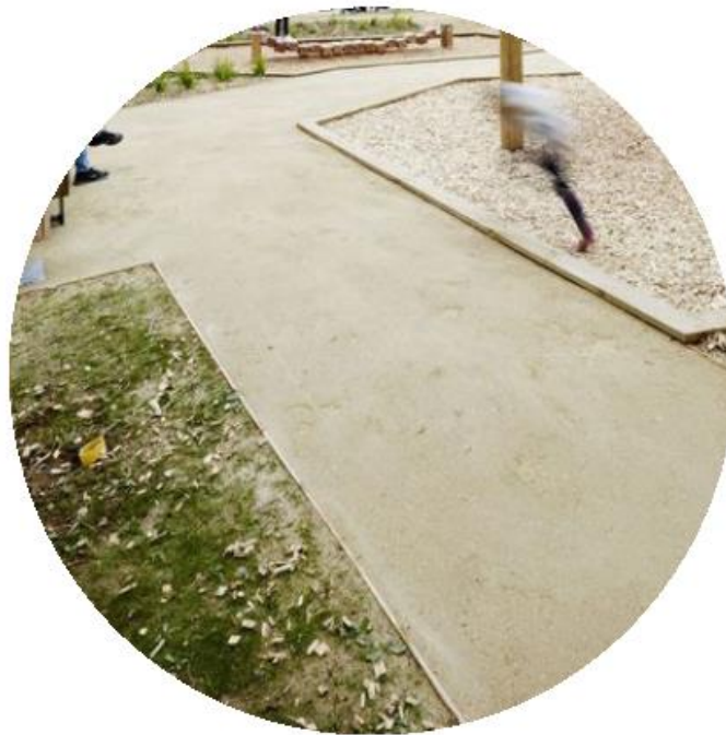
Cheminement en sol drainant type Stabipaq
