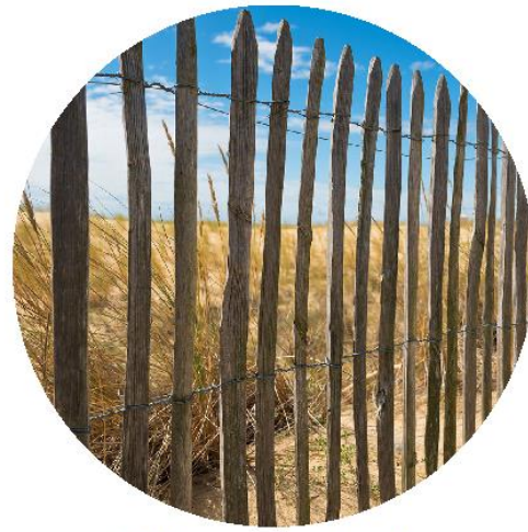
Clôture en ganivelle
